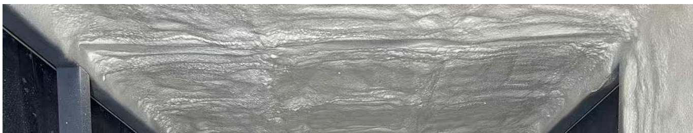
Поверхность сформированного слоя пенополиуретана.
