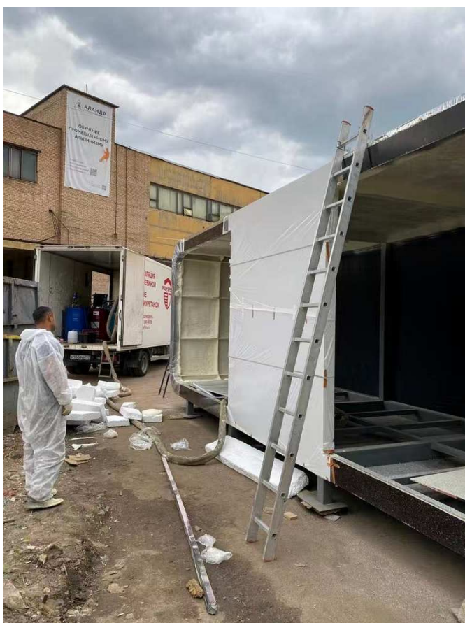
Работы на этапе изготовления капсульного дома.
