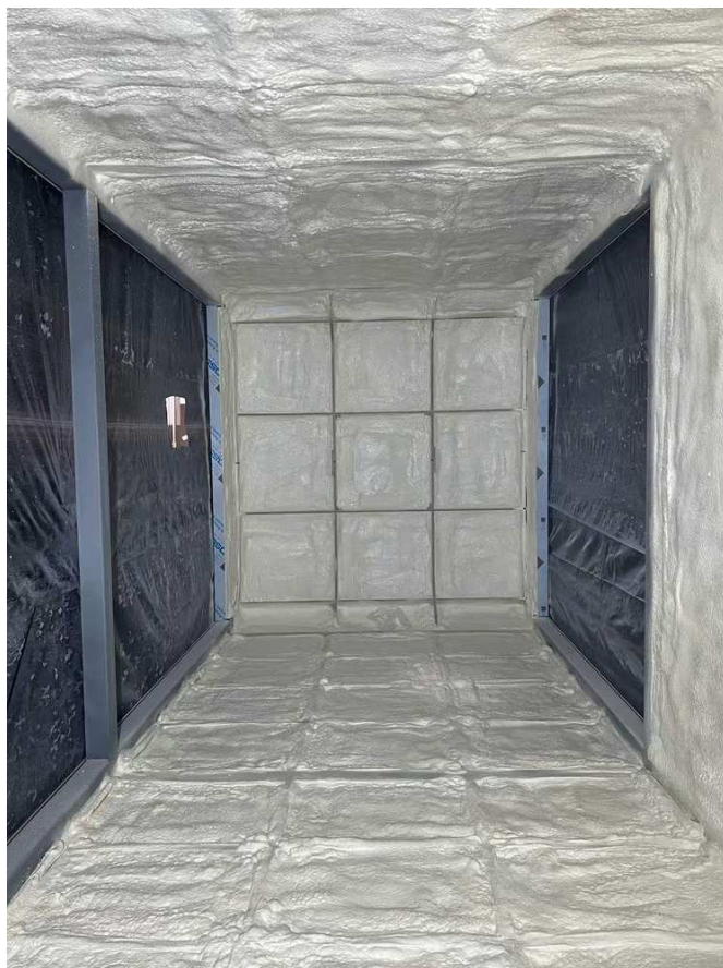
Пол и стены после напыления ППУ.
