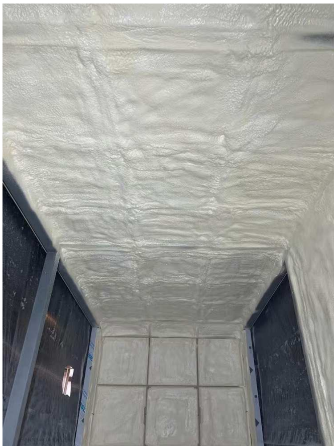
Утепление потолка и торцевой части модуля.
