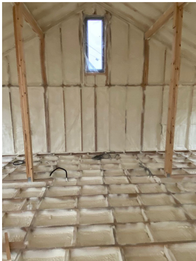
Пол и ограждающие конструкции после напыления.
