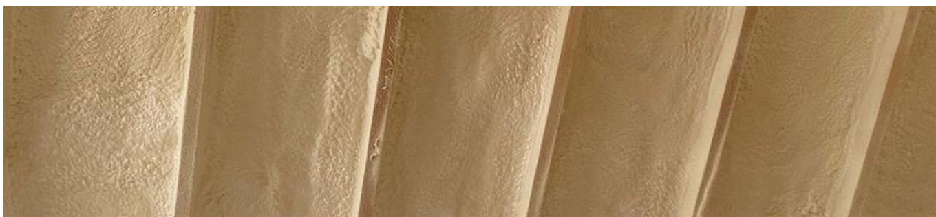
Крупный план теплоизоляции: непрерывный слой между элементами каркаса.
