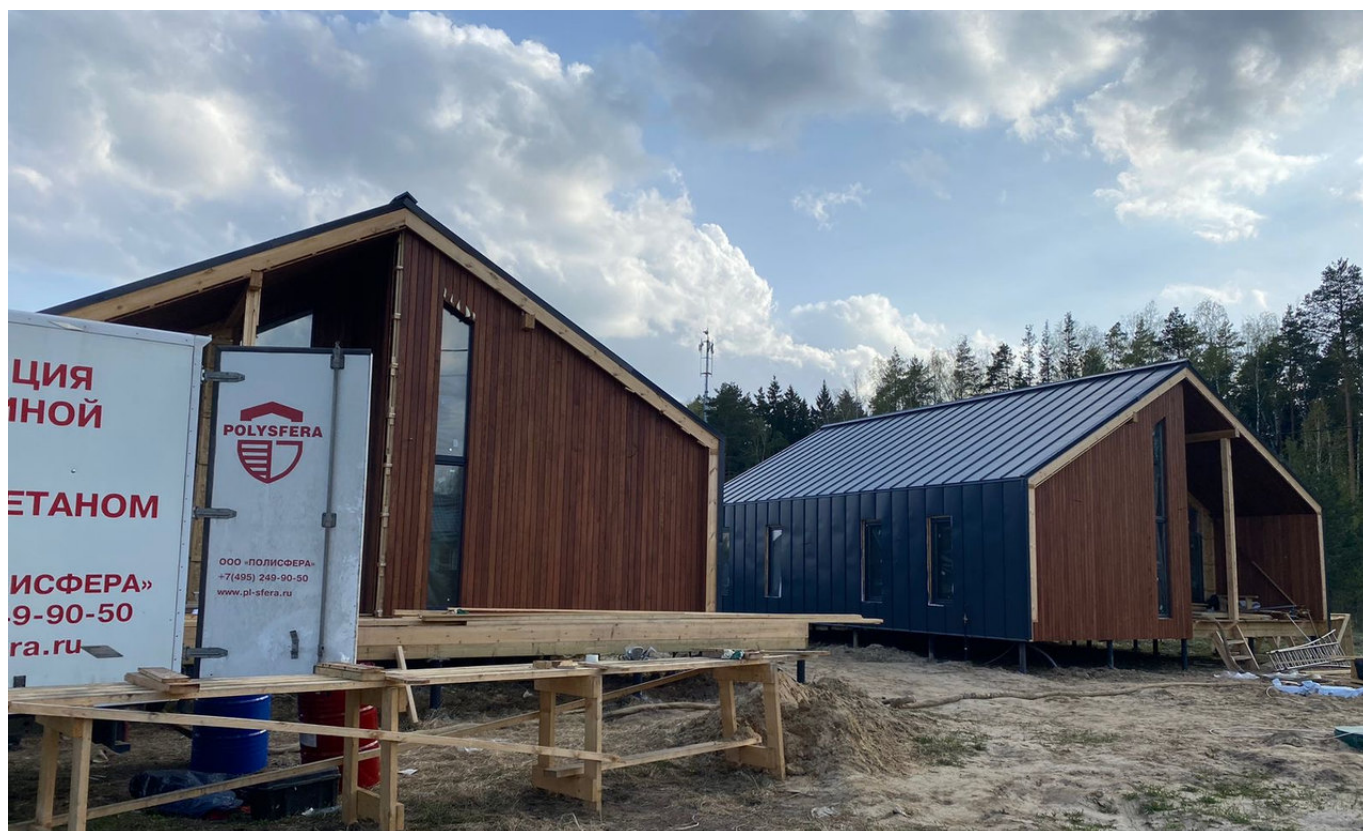
Каркасные дома в стиле барнхаус на строительной площадке. Объект работ «Полисферы».
