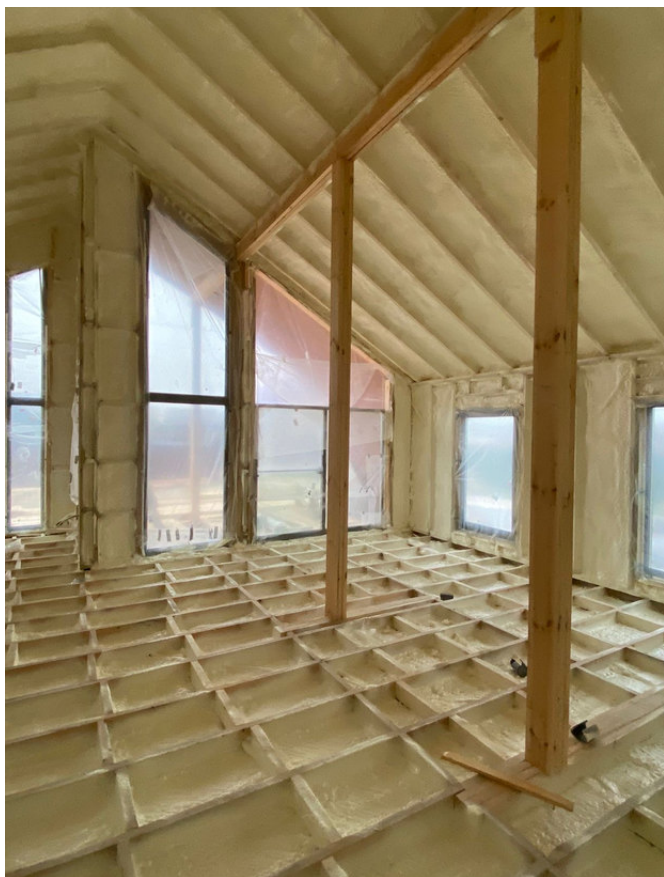
Слой ППУ на стенах и кровельных скатах.
