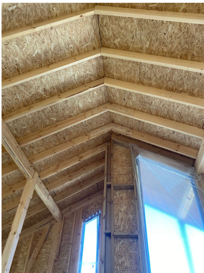
Скаты кровли и OSB-обшивка до утепления.
