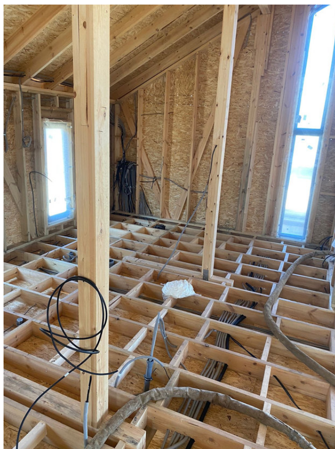
Каркас пола с проложенными коммуникациями.
