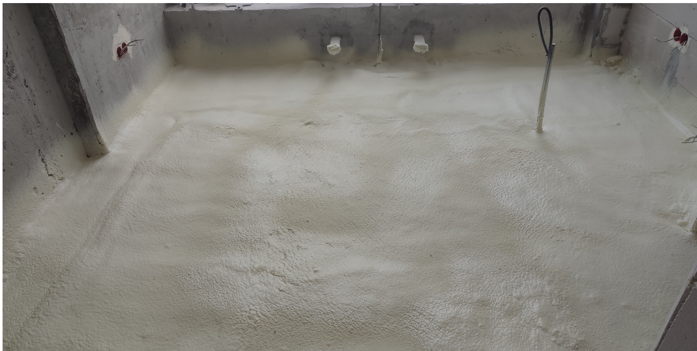
Общий вид напылённого пола. Выводы коммуникаций сохранены.
