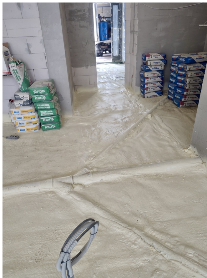
Теплоизоляция в зоне проходов и примыканий к стенам.
