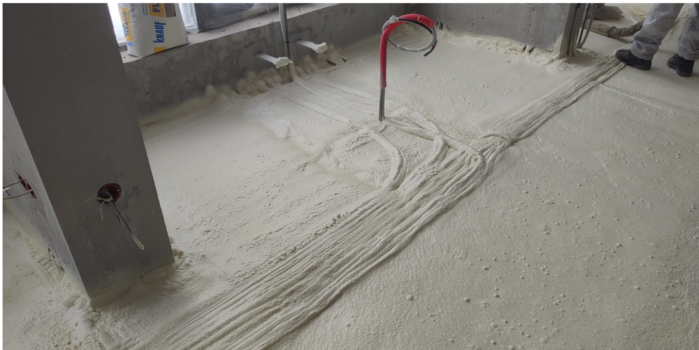
Теплоизоляция в местах прохождения инженерных линий и у строительных конструкций.
